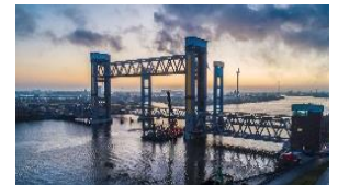
Hubbrücke Kattwyk Hamburg © Kolbeck Fotografie
