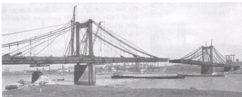
Anheben der Brücke durch Schrägseile und Tragkabel
