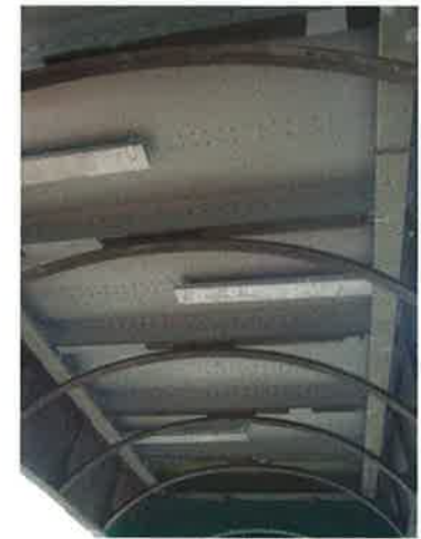
13 Ausgeführte SPS-Verstärkung © Eiffel Deutschland Stahltechnologie GmbH
