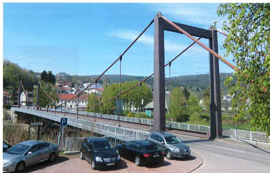
14 Hängebrücke über die Saar in Mettlach © Eiffel Deutschland Stahltechnologie GmbH
