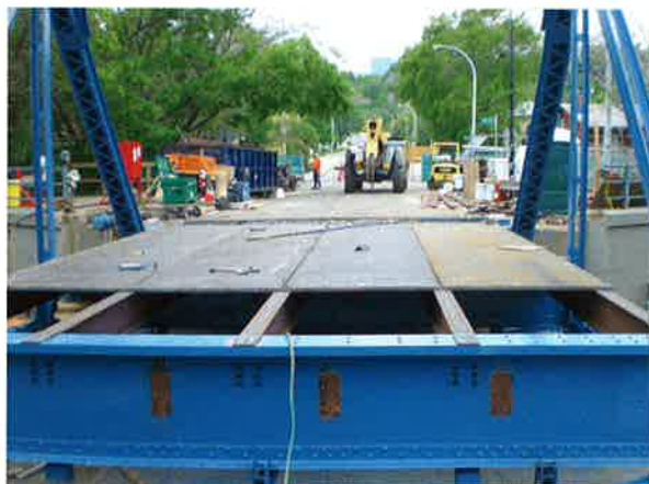
2 Fahrbahndeck einer kanadischen Brücke in SPS-Bauweise © Intelligent Engineering Ltd.
