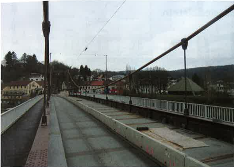
19 Ausführungssituation am 5. Februar 2013 © Eiffel Deutschland Stahltechnologie GmbH
