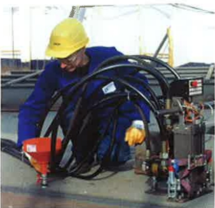
10 Mischkopf für die Elastomerinjektion © Intelligent Engineering Ltd.
