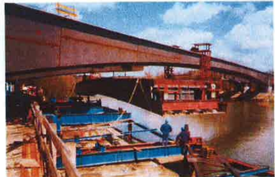
Nördliches Mittelteil mit Dichtschott und Anhebetraverse im Treppenstoß beim Querverschub
