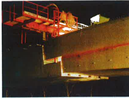
Bild 13: Angehobenes Mittelteil zwischen den beiden Kragarmen
