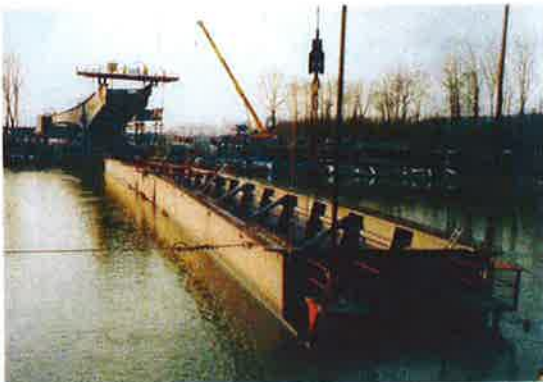
Schwimmendes Mittelteil während des Positionierens im Inn
