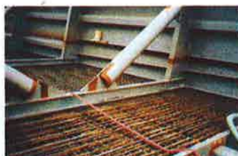
Querschnitt im Voutenbereich, Konstruktion, Fertigung, Betonierzustand
