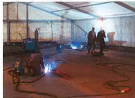
Bild 7. Schweißen des Deckbleches
