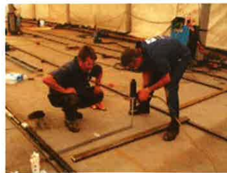
Bild 9. Kleben der Randleisten
