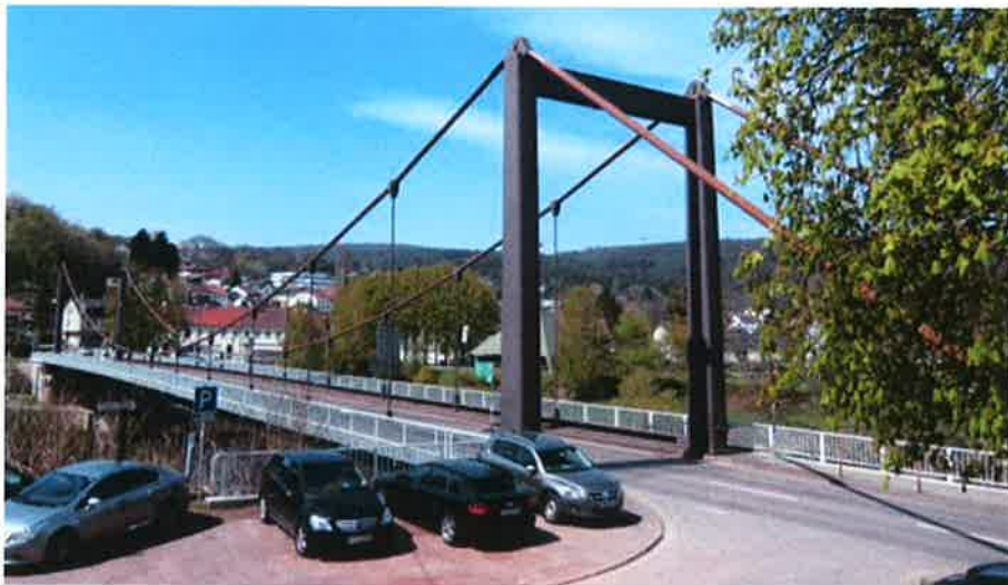
Bild 15. Hängebrücke Mettlach (Sicht vom südlichen Widerlager )
