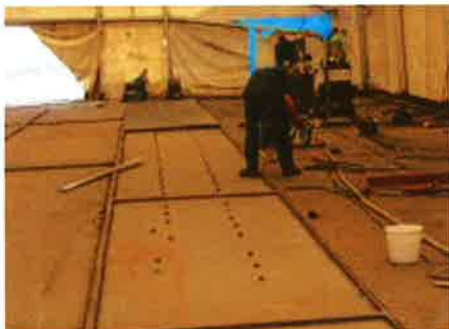
Bild 6. Randleistenrahmen bei SPS-Overlay
