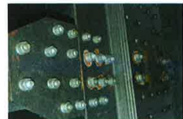
Örtliche Querträgerverstärkungen © Eiffel Deutschland Stahltechnologie GmbH
