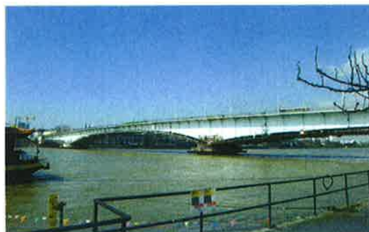
Oberstromseitiger Überbau © Eiffel Deutschland Stahltechnologie GmbH
