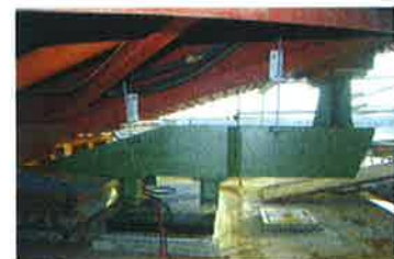
Anhebekonstruktion als Ersatz für nicht nutzbare Pressenansatzpunkte © Eiffel Deutschland Stahltechnologie GmbH
