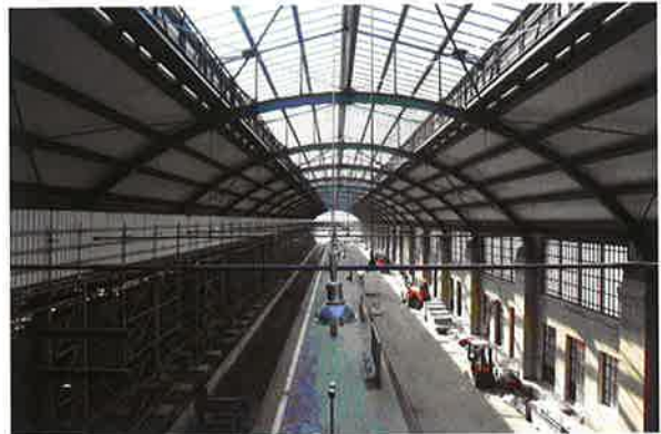
Neubau Laterne Halle 2 © Lothar Mantel, DB ProjektBau GmbH
