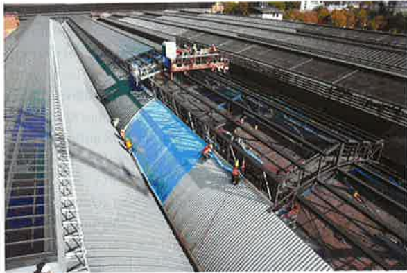
Innenansicht der ersten fertiggestellten Halle © Lothar Mantel, DB ProjektBau GmbH
