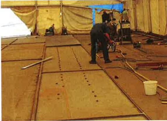
Bild 6: Randleistenrahmen bei SPS-Overlay
