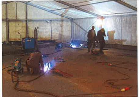
Bild 7: Schweißen des Deckbleches
