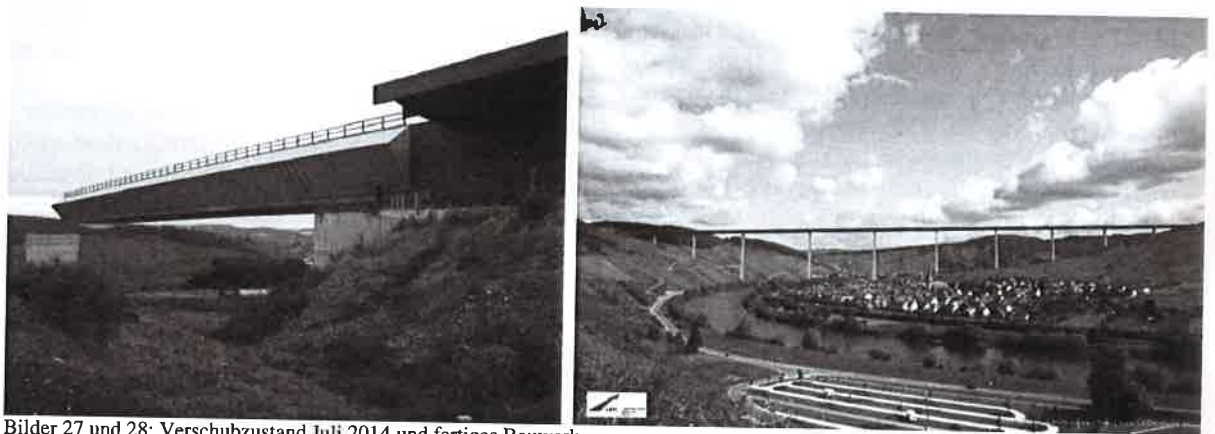
Bilder 27 und 28: Verschubzustand Juli 2014 und fertiges Bauwerk
