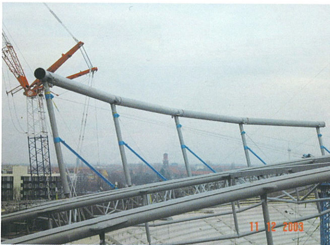
Bild 12. Montagezustand mit Ring A, B und C Fig. 12. State of assembling with ring A, B and C
