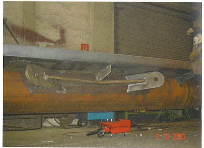
Bild 13. Anschluss des Verbandes BC an den Ring B Fig. 13. Connection of framework BC to ring B
