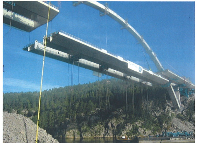
Bild 16. Einhub des Mittelteils Fig. 16. Lifting of the middle section
