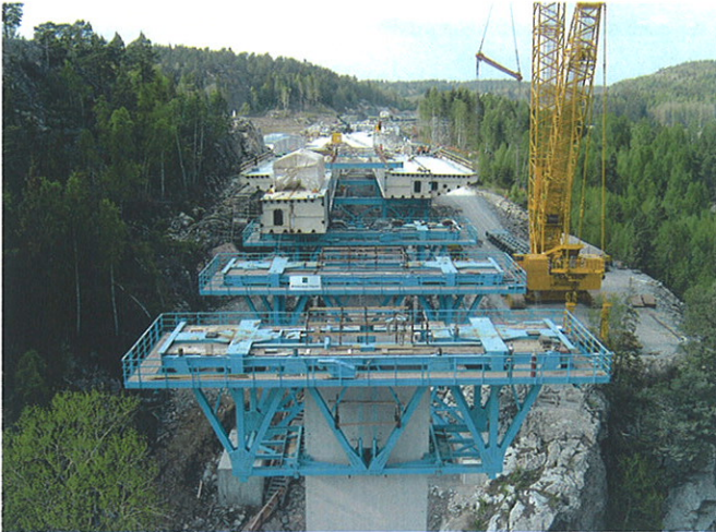
Bild 10. Pfeilerkopf- Gerüste und Hilfsstützen Fig. 10. Auxiliary structure on pier head and stanchion
