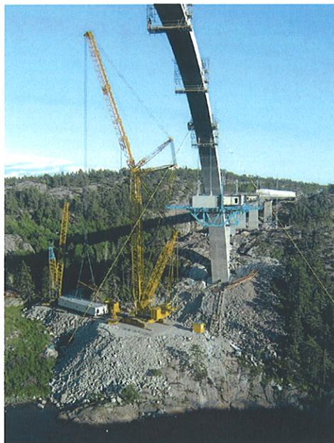
Bild 12. Großkranmontage Schweden/Norwegen Fig. 12. Erection by lifting method with crane Sweden/Norway
