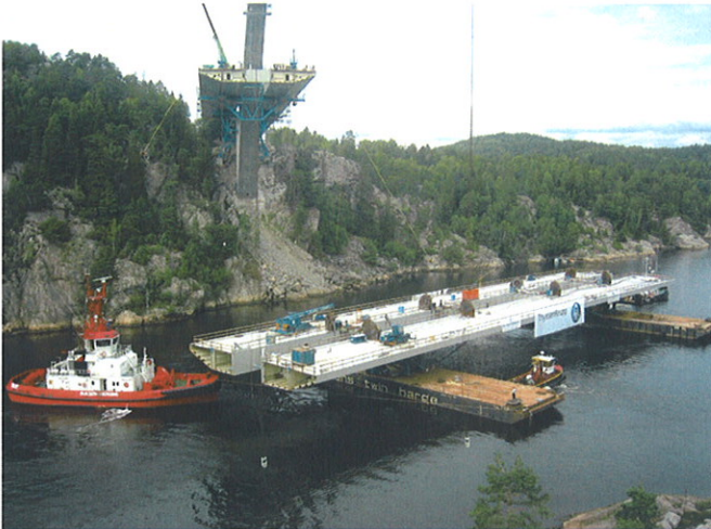
Bild 15. Mittelteil auf Pontons beim Positionieren unter dem Bogen mittels Schubschiff und Seilwinden Fig. 15. Middle section on pontons. Alignment in the line of the arch by tugboat and winches
