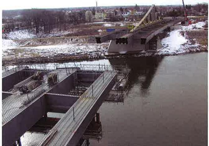
Bild 15. Brückenquerschnitt bei Vorschub
