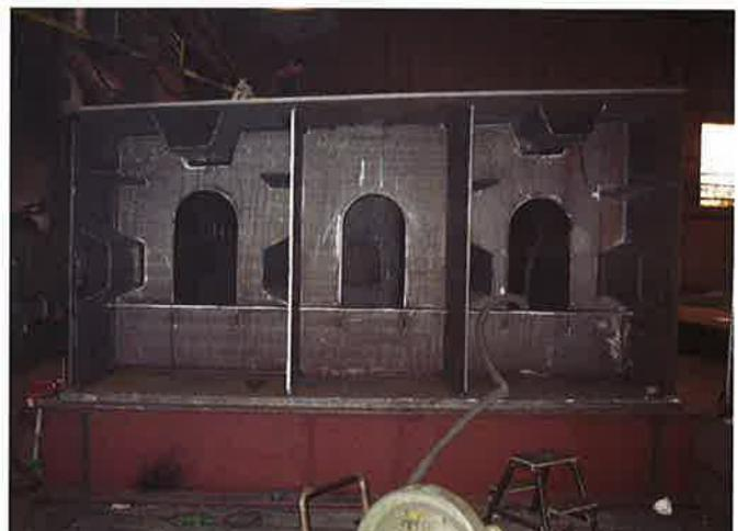
Bild 9. Werkstattfertigung mittlerer Hohlkasten
