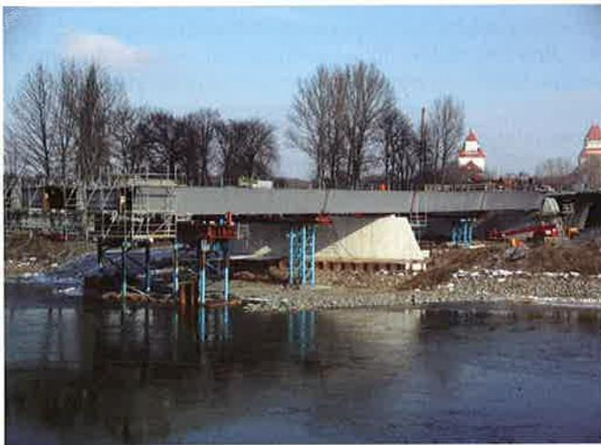
Bild 10. Die in Endlage montierte Ostseite
