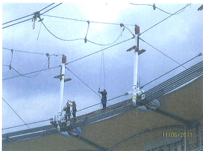
Bild 16. Hubvorgang abgeschlossen, Trageil bereit zum Einbolzen Fig. 16. Cable net lift finished
