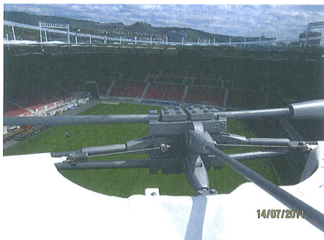
Bild 18. Seilknöten mit Anschluss der Membran Fig. 18. Cable joint with fixed membrane
