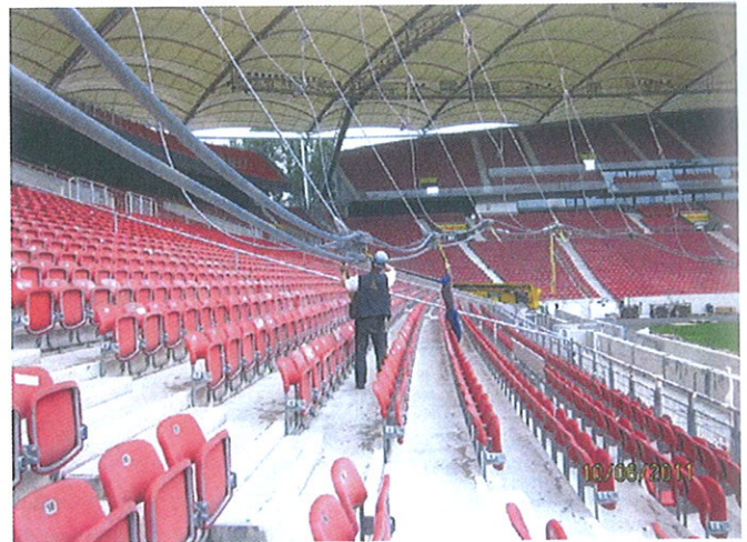
Bild 14. Lösen der Abspannungen Fig. 14. Unlocking the temporary guys
