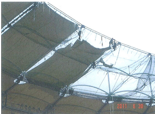
Bild 19. Montage Membranfelder Fig. 19. Installation of the membrane canvas
