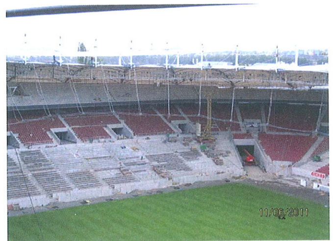
Bild 15. Seiltragwerk im oberen Hubbereich Fig. 15. Cable net lift
