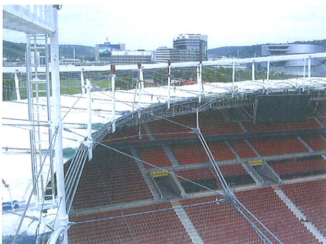
Bild 17. Gespanntes Seiltragwerk Fig. 17. Prestressed cable net
