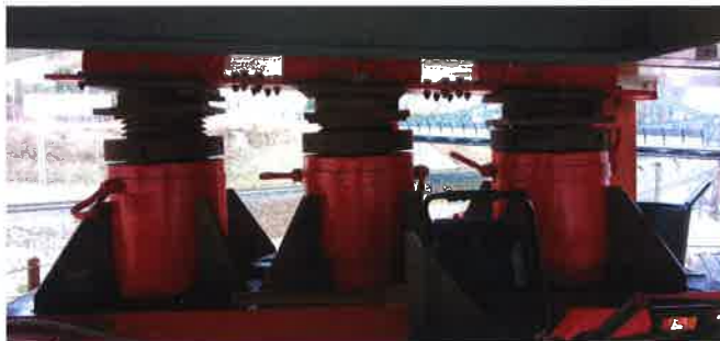
17 Verschublager mit hydraulischer Kopplung © SEH Engineering GmbH
