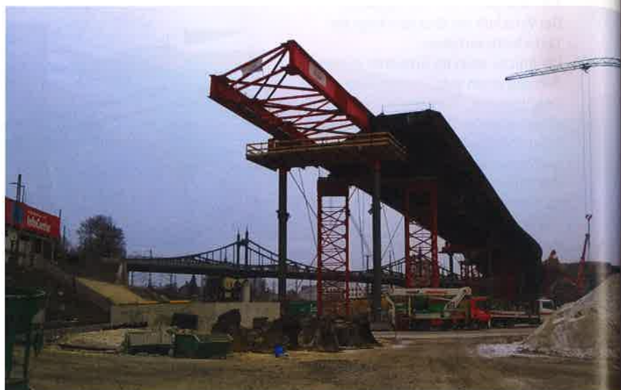
21 Stützenkonstruktion mit Kupferweiterung und Überbau mit Vorbauschnabel © SEH Engineering GmbH
