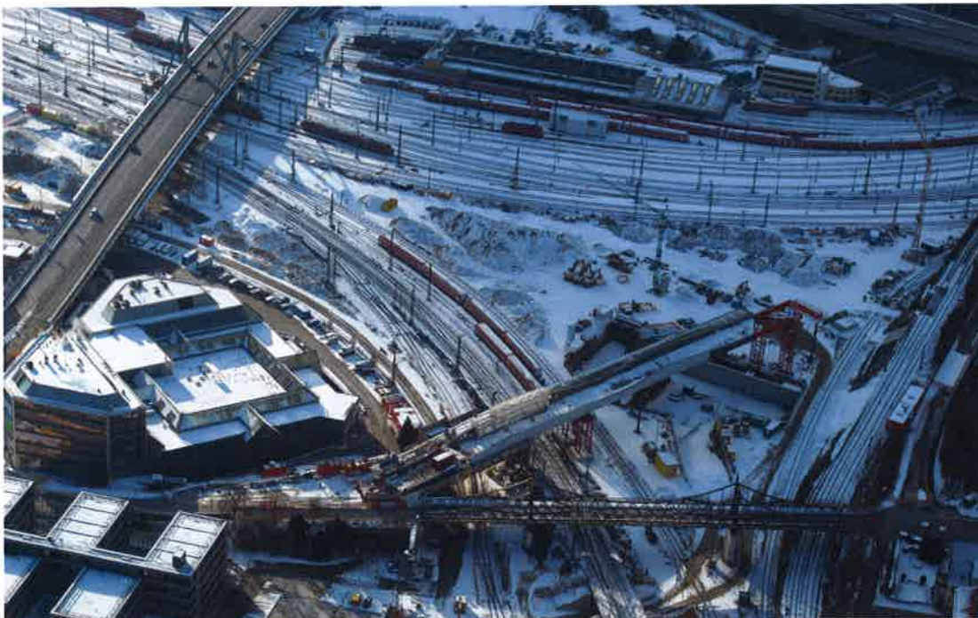
11 Aktuelle Bausituation in Ulm © SWU Stadtwerke Ulm/Neu-Ulm GmbH
