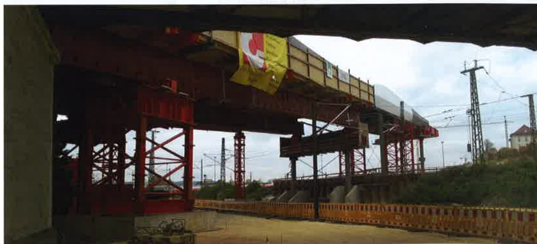
15 Montageplattform nach Errichtung © SEH Engineering GmbH
