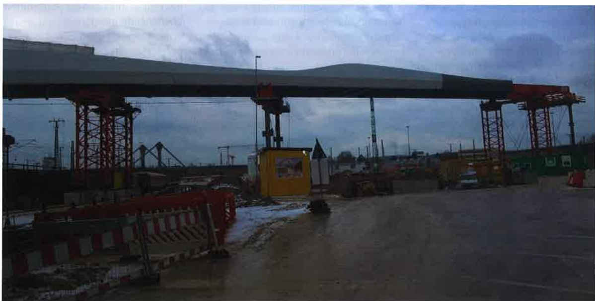
27 Hauptträger mit temporärer Verlängerung im Bahnbereich mit Parallelbaustellen © SEH Engineering GmbH
