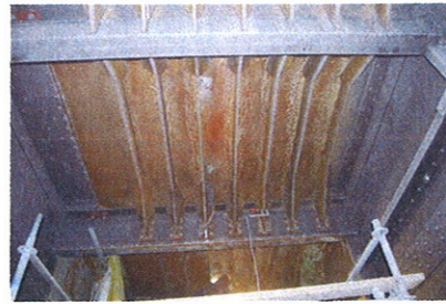
12 Ausgeführte Tonnenblechverstärkung © Eiffel Deutschland Stahltechnologie GmbH
