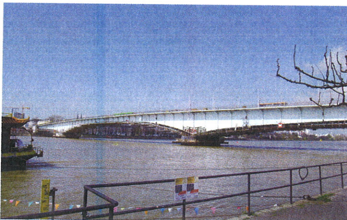
4 Oberstromseitiger Überbau © Eiffel Deutschland Stahltechnologie GmbH
