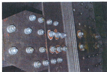
9 Örtliche Querträgerverstärkungen © Eiffel Deutschland Stahltechnologie GmbH
