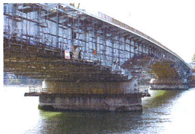
7 Hängegerüst unter der Brücke © Eiffel Deutschland Stahltechnologie GmbH
