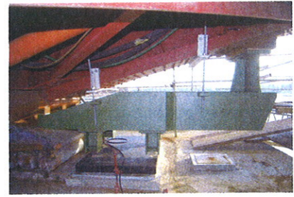
8 Anhebekonstruktion als Ersatz für nicht nutzbare Pressenansatzpunkte © Eiffel Deutschland Stahltechnologie GmbH
