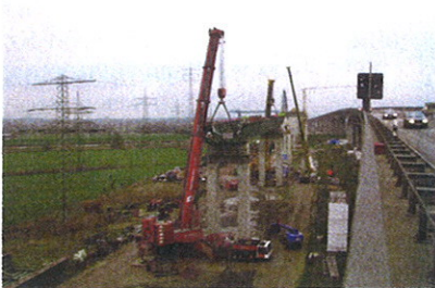
9 Montage eines Hohlkastens der Vorlandbrücke © Landesbetrieb Straßenbau und Verkehr Schleswig-Holstein
