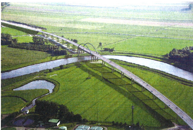
13 Fertiggestellter Ersatzneubau © Ingenieurbüro Grassl GmbH
