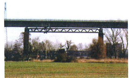
2 Gerbergelenk des heutigen Bauwerks © Landesbetrieb Straßenbau und Verkehr Schleswig-Holstein
