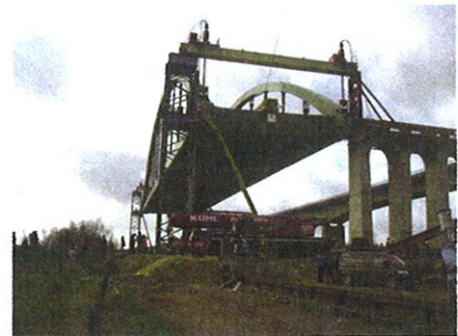
7 Anheben des Stabbogens mit Litzenhebern © Landesbetrieb Straßenbau und Verkehr Schleswig-Holstein
