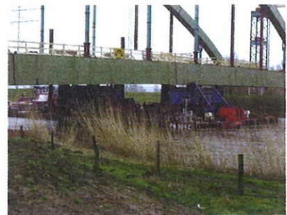
6 Längsverschub des Stabbogens mit Ponton © Landesbetrieb Straßenbau und Verkehr Schleswig-Holstein
