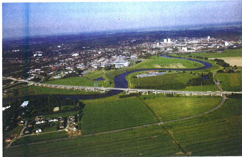
1 Vorhandene Störbrücke © Landesbetrieb Straßenbau und Verkehr Schleswig-Holstein
