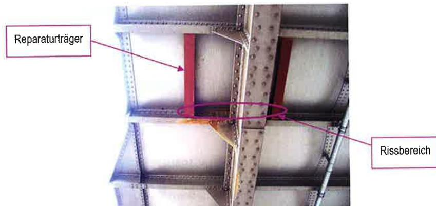
1 Typisches Schadensbild an den Tonnenblechen: Riss am Querträgeranschluss
