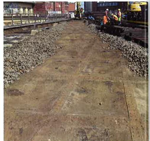
21 Baufeld nach Rückbau von Gleisen und Schotter
