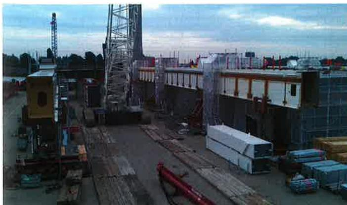
18 Montage: Versteifungsträger und (nachlaufend) Fahrbahndeck
