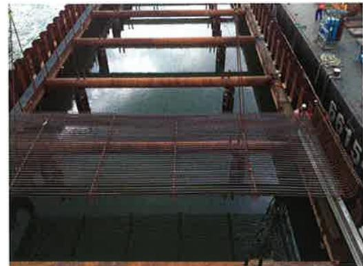
11 Aussteifungskonstruktion im Detail
