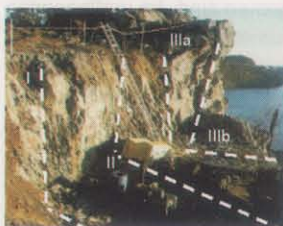
Baugrube des nördlichen Kämpfers [3]
