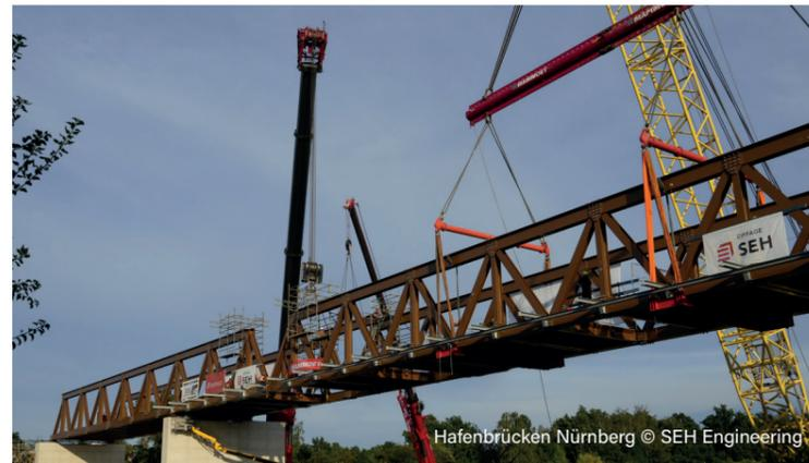
Die nach dem Baukastenprinzip einsetzbaren Brücken wurden bisher deutschland- und europaweit an private wie auch öffentliche Kunden geliefert. Die unbegrenzt wieder einsetzbaren, robusten Konstruktionen können schnell und einfach montiert und abgebaut werden. Dank ihrer konstruktiven Flexibilität lassen sich diese Brückengeräte optimal an die jeweiligen Gelände- und Verkehrssituationen anpassen.
