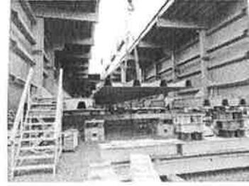
Bilder 12,13 und 14: Zusammenbau des Hohlkastens auf dem Vormontageplatz und Aufkanten
