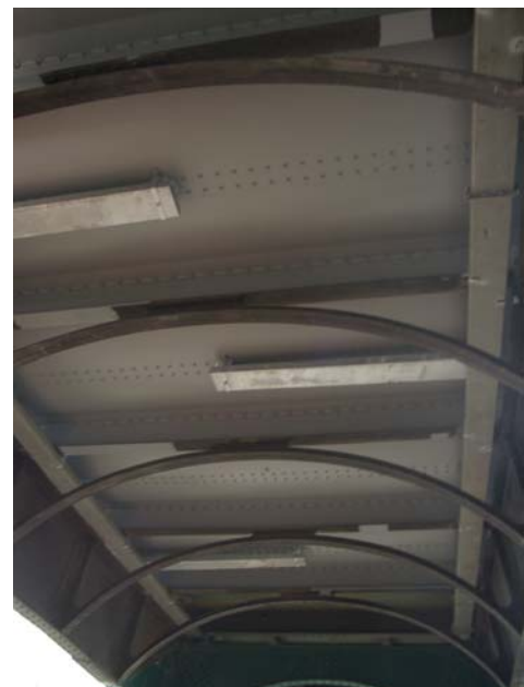
Bild 13. Ausgeführte SPS-Verstärkung Fig. 13. ready-made SPS reinforcement
