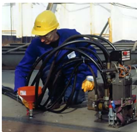
Bild 10. Mischkopf für Elastomerinjektion Fig. 10. Injection head for elastomer injection
