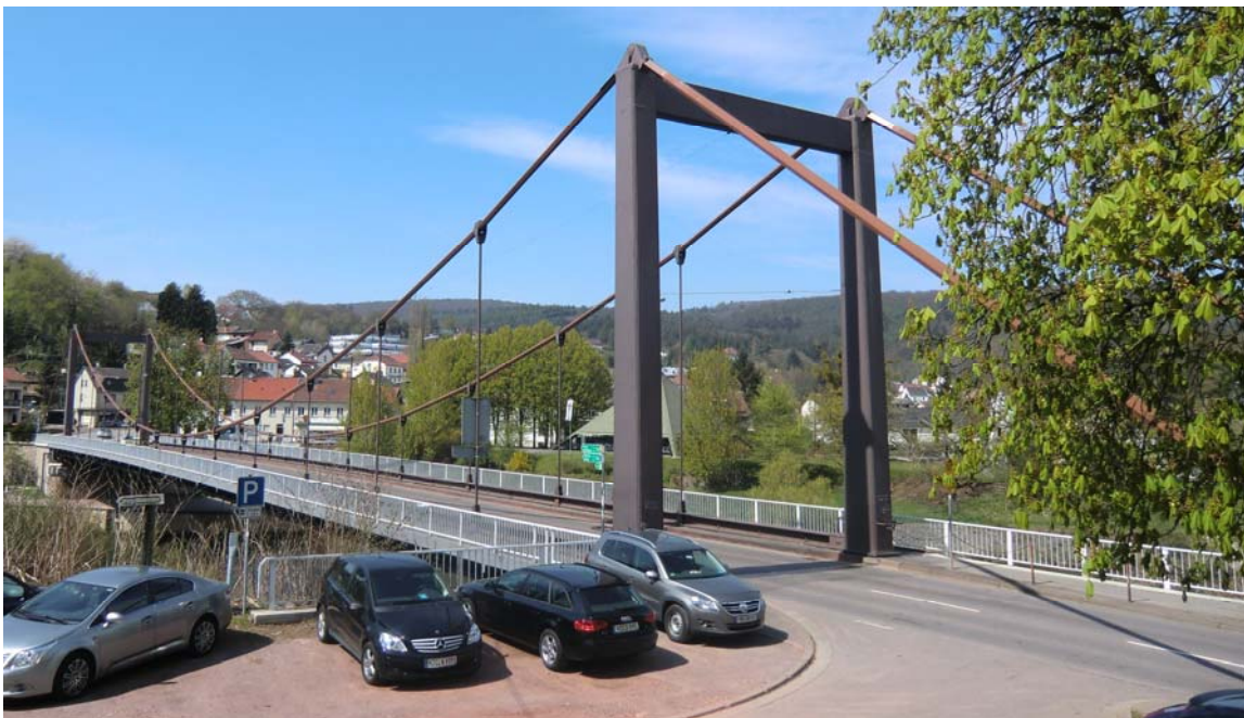
Bild 14. Hängebrücke Mettlach (Sicht vom südlichen Widerlager ) Fig. 14. Suspension bridge Mettlach (view from south)
