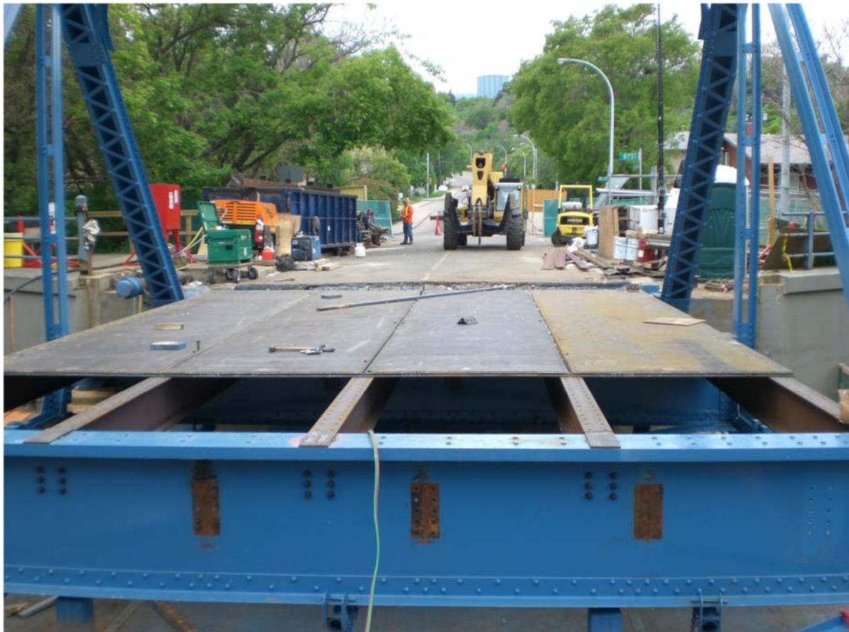
Bild 2. Fahrbahndeck einer kanadischen Brücke in SPS-Bauweise (Dawson-Bridge) Fig. 2. SPS-Bridge deck of Canadian Dawson-Bridge
