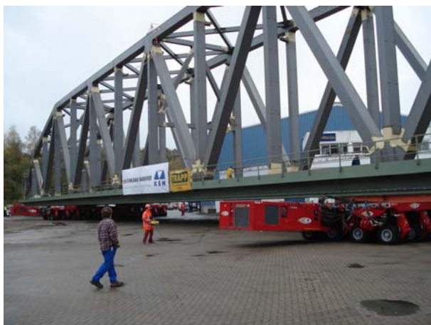
Bild 5 Brücke mit Plattformwagen auf Ponton
