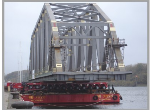
Bild 11 Neuer Schwebeträger mit Ponton
