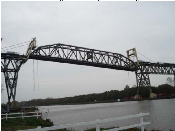
Bild 10 Absenken des alten Schwebeträgers
