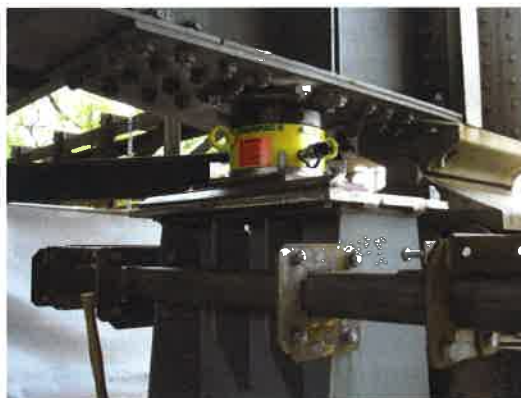
Montagerüst mit Rollenlager vor dem Einschub, Grundplatte bereits eingebaut © Eiffel Deutschland Stahltechnologie GmbH
