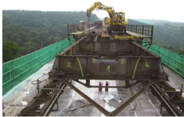
Kleinteiliger Rückbau der Fahrbahnbrücke © Eiffel Deutschland Stahltechnologie GmbH
