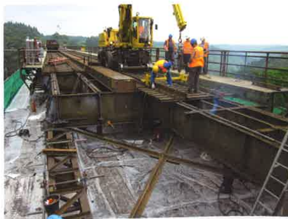
Demontage mittels Zwei-Wege-Technik © Eiffel Deutschland Stahltechnologie GmbH
