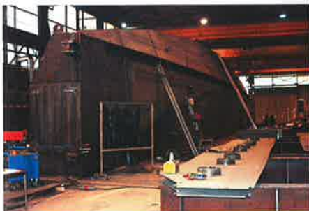
Zusammenbau von Riegel 1 in der Werkshalle © Eiffel Deutschland Stahltechnologie GmbH
