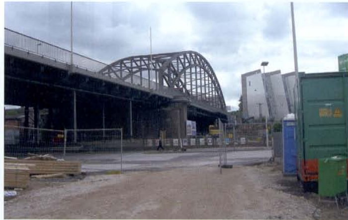
Verkehrssituation © Eiffel Deutschland Stahltechnologie GmbH
