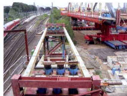
Baustraße während des Einfahrvorganges
