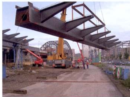
Montage Rampenbrücke © Eiffel Deutschland Stahltechnologie GmbH
