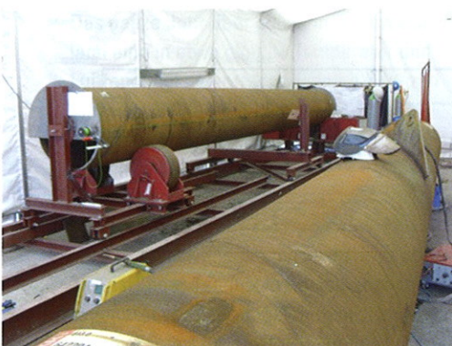
Vorrichtung zur Stabherstellung © Eiffel Deutschland Stahltechnologie GmbH
