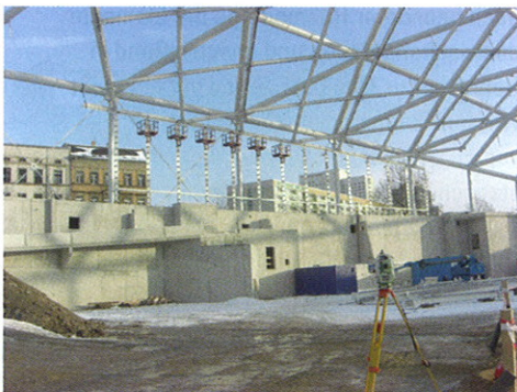
Montage der Sekundärkonstruktion © Eiffel Deutschland Stahltechnologie GmbH
