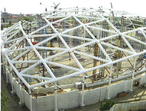
75 % des Primärdaches ... © Eiffel Deutschland Stahltechnologie GmbH
