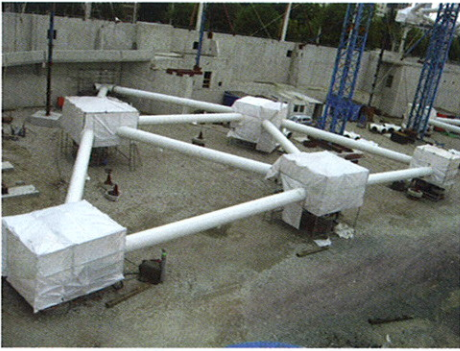
Vormontage der Hubelemente © Eiffel Deutschland Stahltechnologie GmbH
